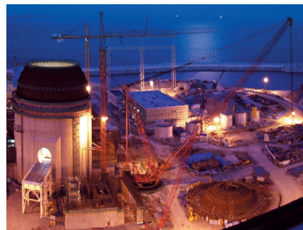
Slika 2.4.4.5-2.: Građevinski radovi u elektrani Shin-Kori
