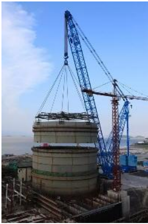
Slika 2.4.4.1-1.: Udizanje trećeg kontejner prstena na lokaciji Sanmen 1.
