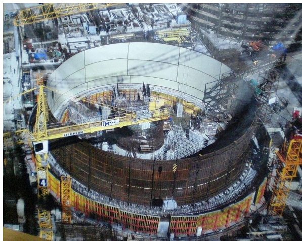
Slika 2.4.4.2-1.: Blok elektrane u izgradnji u Sosnovij Boru
