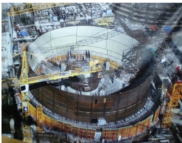
Figura 2.4.4.2-1.: Blocul centralei nucleare în construcție la Sosnovi Bor
