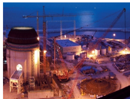
Figura 2.4.4.5-2.: Lucrări de construcție la centrala Shin-Kor
