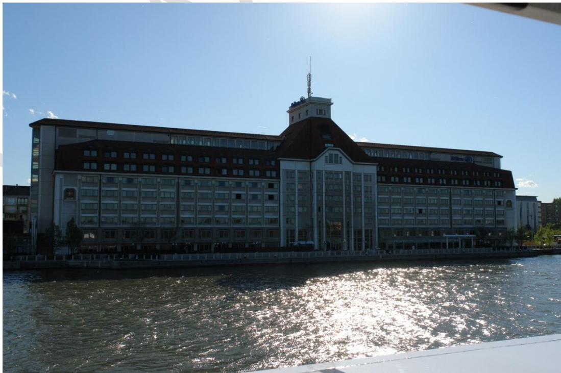
Bécs – az egykori gabonatórház az átépítés után - ma HILTON Hotel
