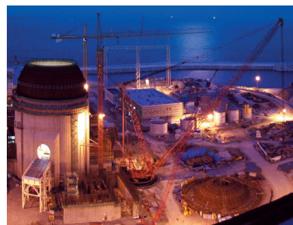
Obrázok 2.4.4.5-2: Stavebné práce v elektrárni Shin-Kori
