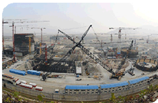
Obrázok 2.4.4.4-2: Stavebné práce na Taishan 1-2
