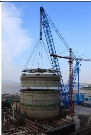
Obrázok 2.4.4.1-1: Ukladanie 3. prstenca containmentu v prevádzke Sanmen 1
