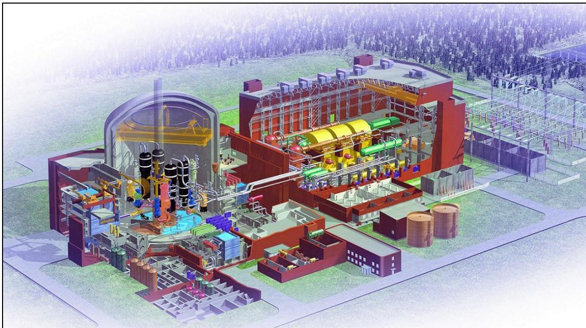
Obrázok 2.4.1.4-1: Maketa bloku EPR budovaného vo fínskom Olkiluoto [19]
