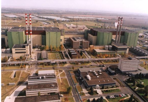
Слика 2.3.1-1.: Поглед на блокове нуклеарне електране Пакш
