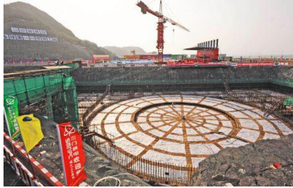
Слика 2.4.4.1-2.: Изградња електране Хаијанг 2
