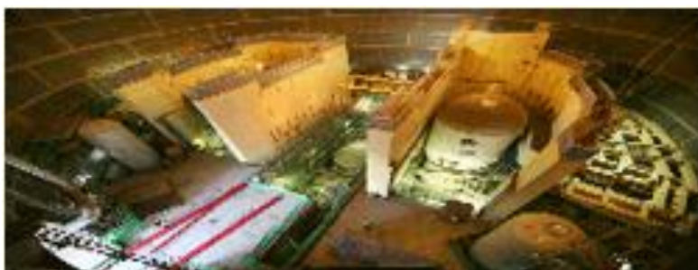
Слика 2.4.4.5-1.: Радови у згради контејнмента на 3. блоку у Шин-Кори
