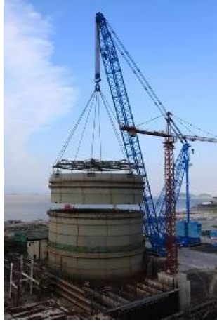
Слика 2.4.4.1-1.: Постављање трећег прстена контејнмента на локацији Санмен 1
