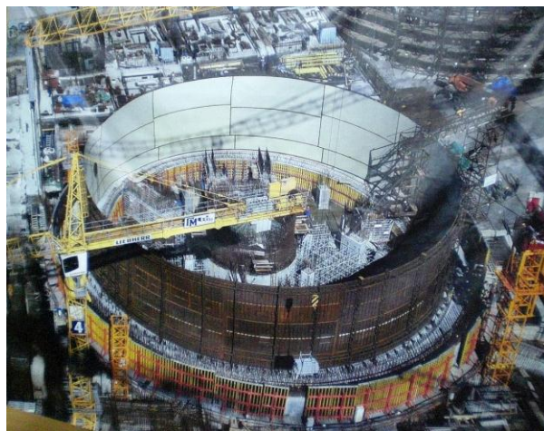
Слика 2.4.4.2-1.: Изградња блока у електрани Сосновиј Бор
