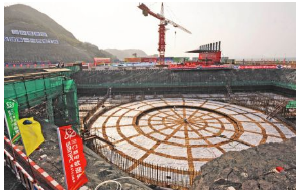
Малюнок 2.4.4.1-2.: Побудова електростанції Хайанг 2.
