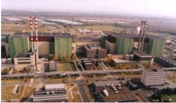
Фотографія 2.3.1 1: Погляд на ядерні блоки електростанцій Пакш
