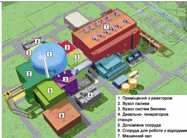
Рисунок 2.2.2.5-1.: Важливі споруди атомної електростанції EPR [5]
