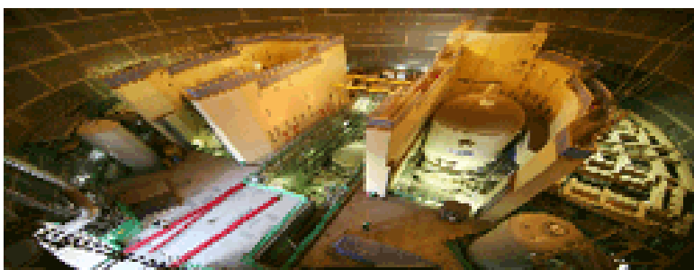
Малюнок 2.4.4.5-1.: Роботи в споруді контейнеру на 3. блоці в м. Шін-Корі
