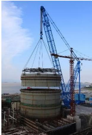
Figure n°2.4.4.1-1: Mise en place du troisième anneau de confinement, sur le site Sanmen 1.
