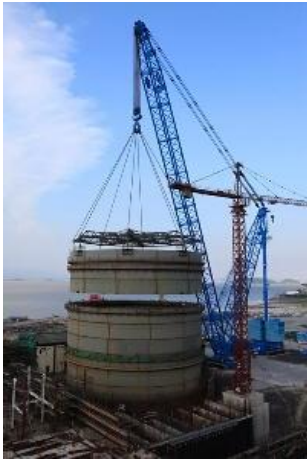
Slika 2.4.4.1-1.: Postavitev tretjega prstana zaščitne zgradbe na lokaciji Sanmen 1.
