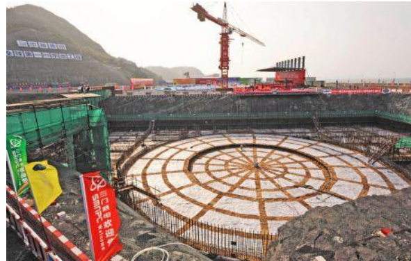
Slika 2.4.4.1-2.: Izgraditev elektrarne Haiyang 2.
