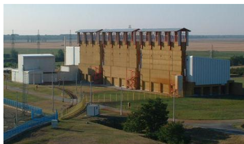
Slika 2.3.2-1.: Začasno skladišče zgorelih kaset
