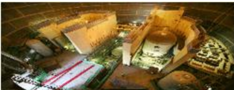
Slika 2.4.4.5-1.: Dela na zaščitni zgradbi 3. bloka v Shin-Kori
