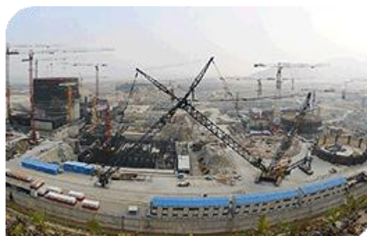
Рисунок 2.4.4.42: Работы по строительству Taishan 1–2.
