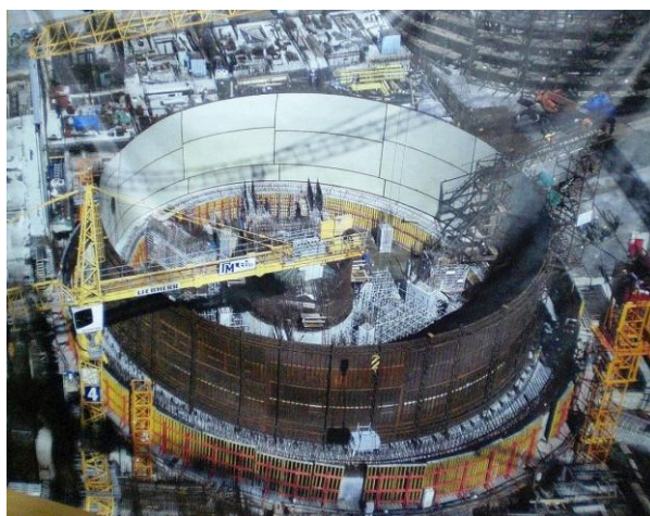
Рисунок 2.4.4.2-1.: Строящийся блок атомной станции в Сосновом Бору
