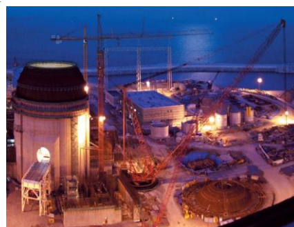
Рисунок 2.4.1.52: Строительные работы на атомной станции Shin-Kori
