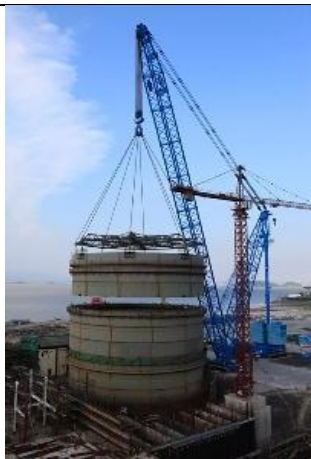
Рисунок 2.4.4.11: Обкладка третьего кольца контейнента на участке Sanmen 1
