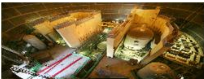
Рисунок 2.4.1.51: Работы в здании контейнента на блоке Shin-Kori 3
